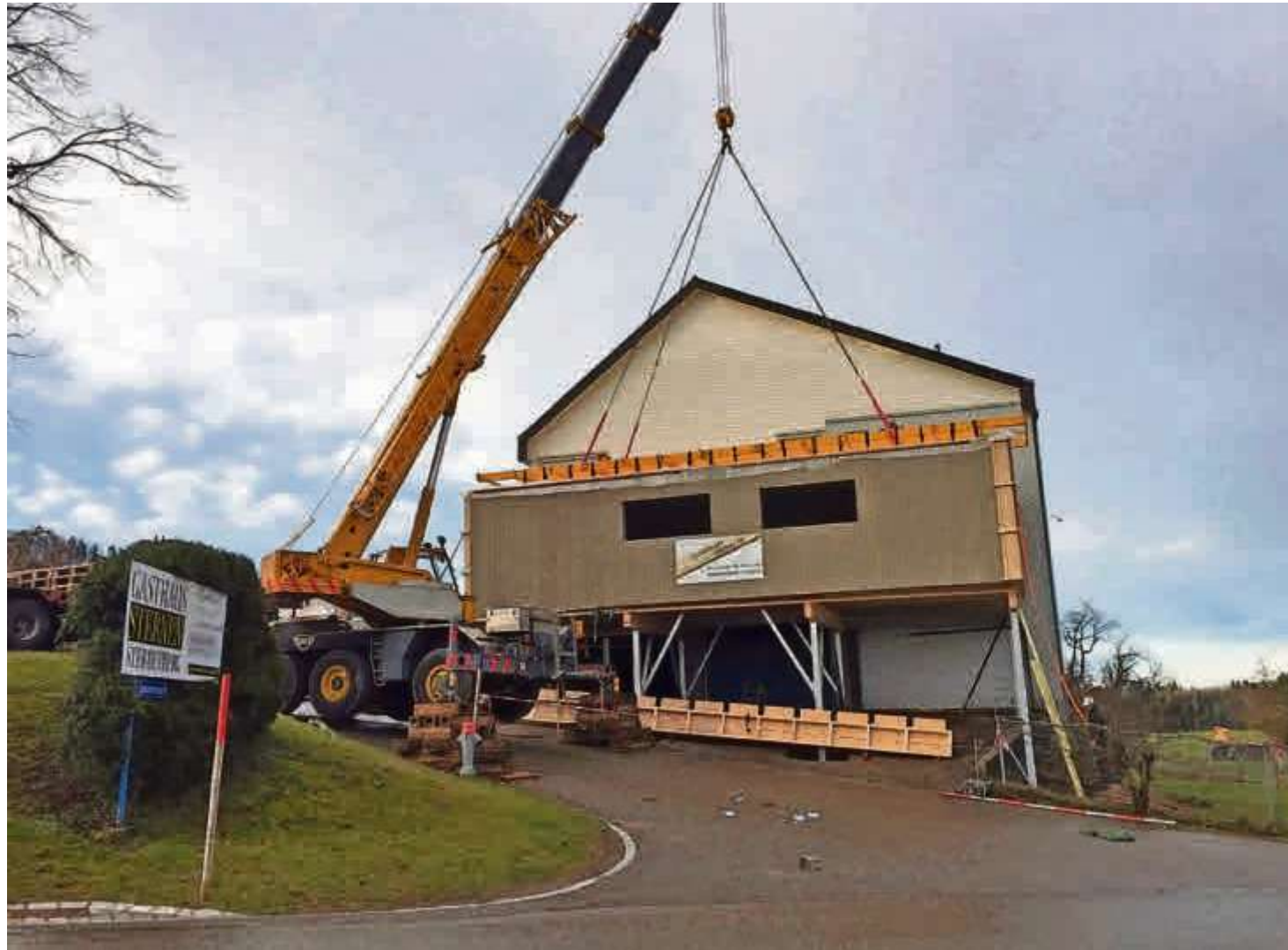
Ein Kranwagen hob den Küchenanbau gestern Morgen an seinen Platz vor der Dépendance, in der das «Sternen»-Provisorium entsteht. Susanne Weiss
